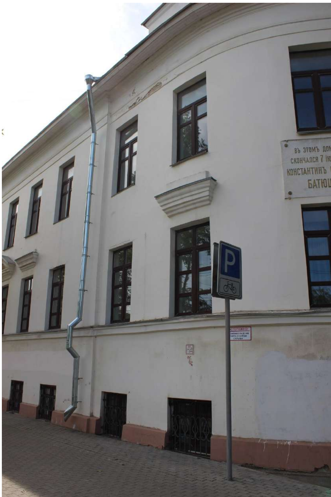
Угол здания и фрагмент фасада по ул. Батюшкова
